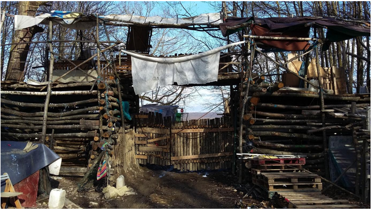
Fig. 14 : Palissade de la ZAD de Roybon, Isère. Source : photographie de l'auteur.
