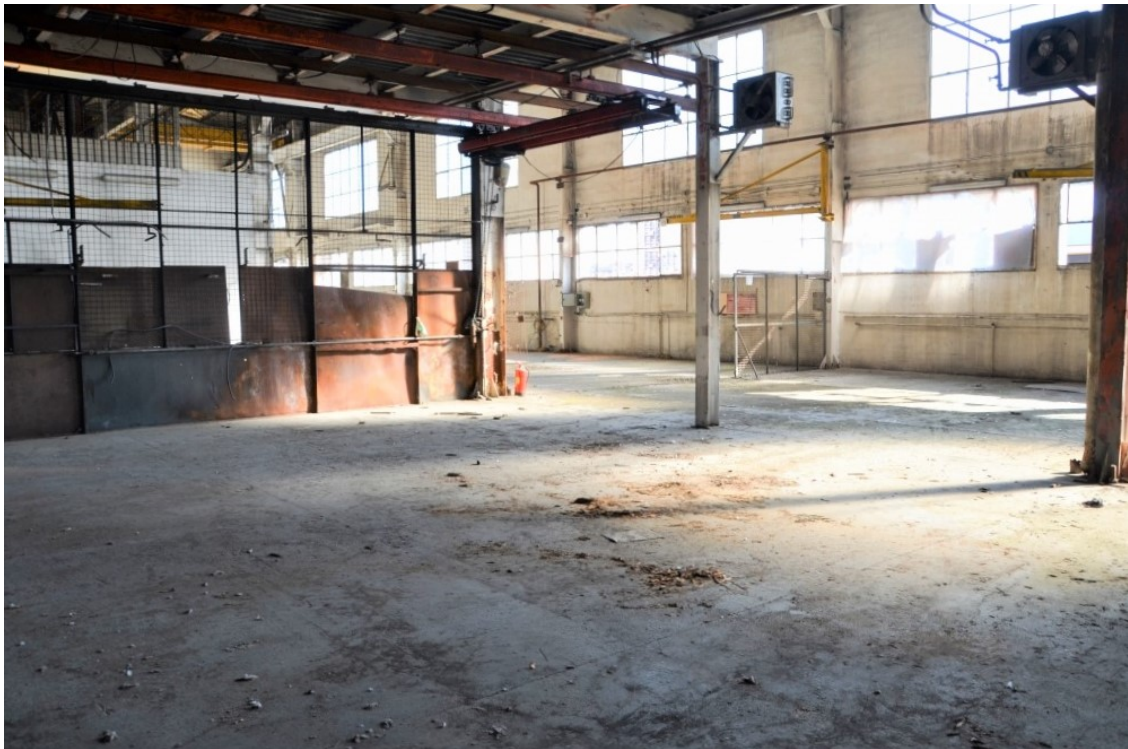
Usine Pillard avant travaux, ©Les 8 Pillards
